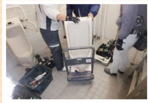
工事中の様子
